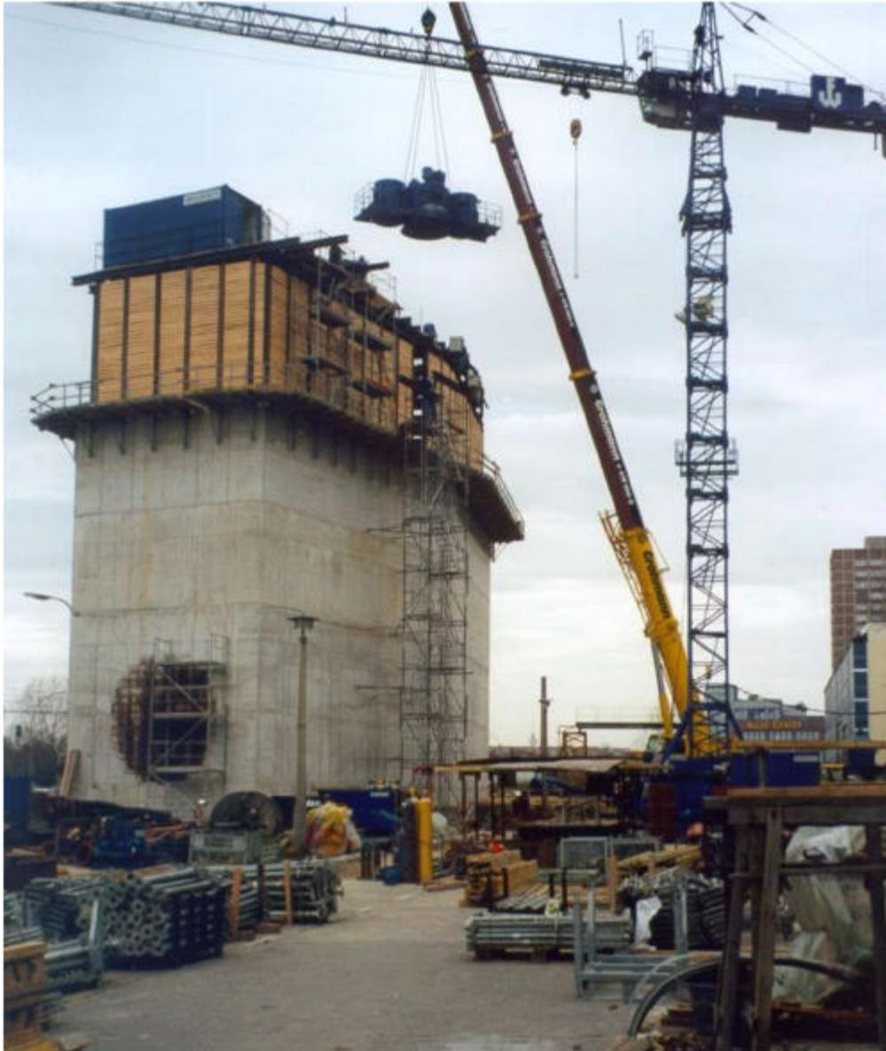
Schacht Nr.7 aus dem gleichzeitig die zwei Rohrvortriebe aufgeföhren wurden
