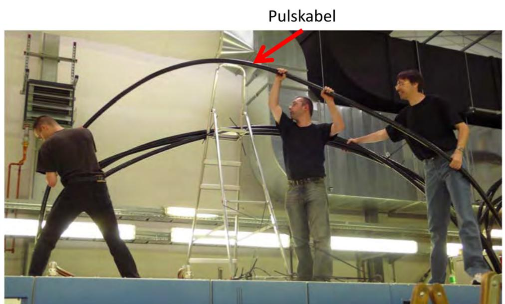
Verlegung und Installation der Pulskabel
